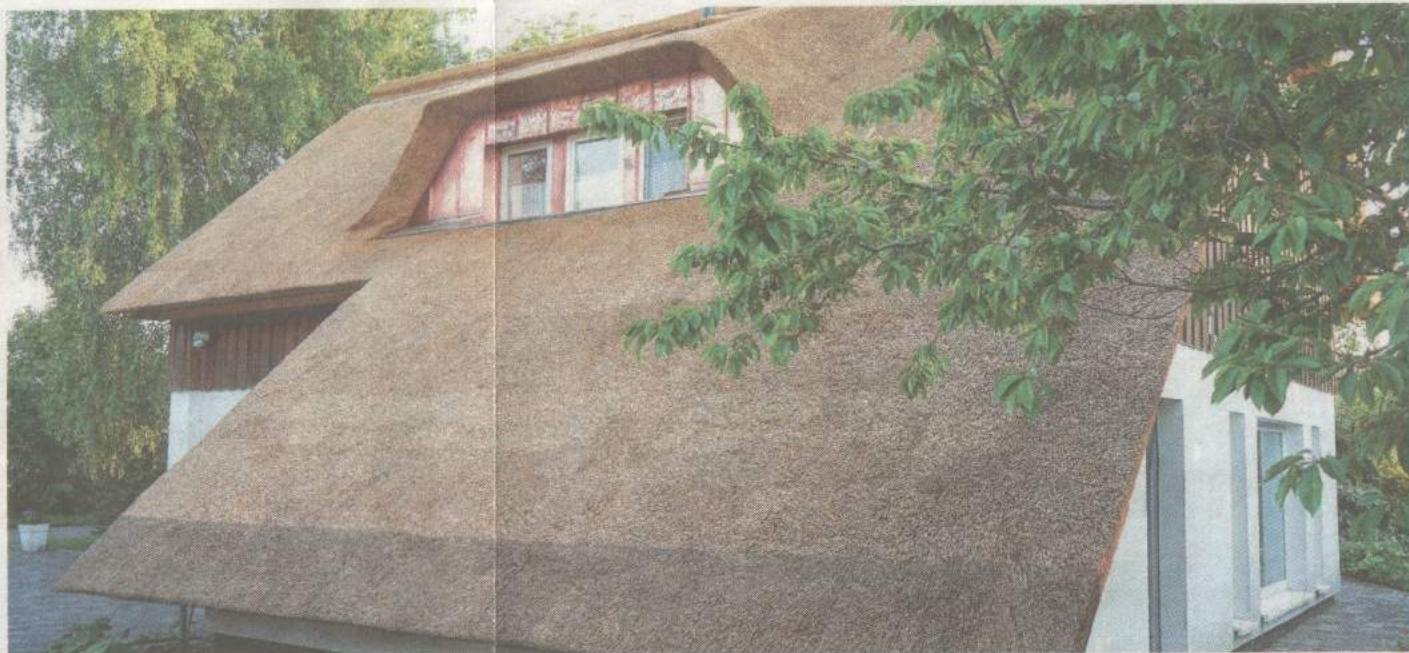
Dieses Reetdach ist kürzlich in Neuendorf-Heide fertig gestellt worden.
